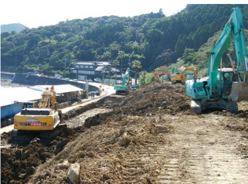
▼約20台の重機で国道220号と小内海駅に流入した土砂を撤去
