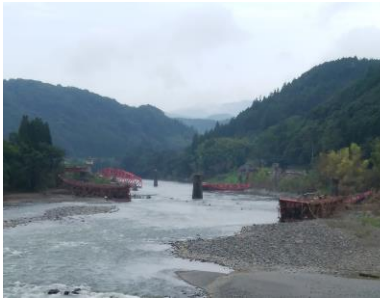
撤去作業に着手した第二球磨川橋梁
