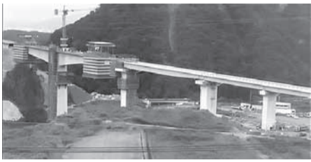
豊肥本線の車窓からは、来春の開通を目指して建設が進む国道57号線の「新阿蘇大橋」を望むことができる
