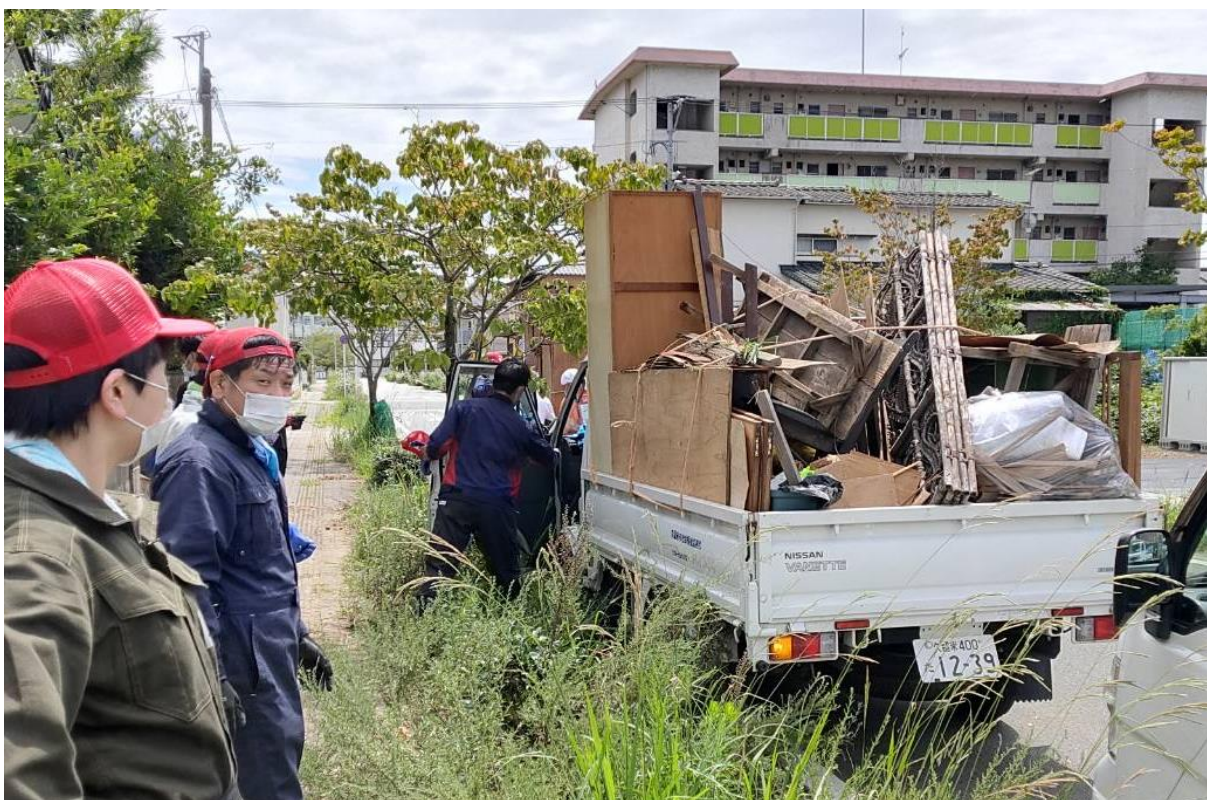
作業で搬出した瓦礫でトラックの荷台がいっぱいに
