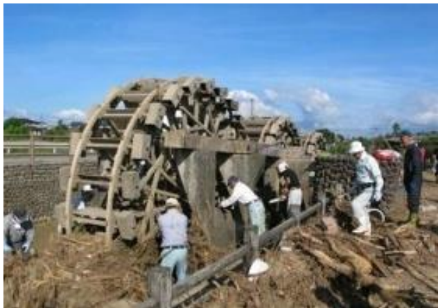
三連水車に絡まった流木などを除去する山田堰土地改良区の役員や関係者7月16日
